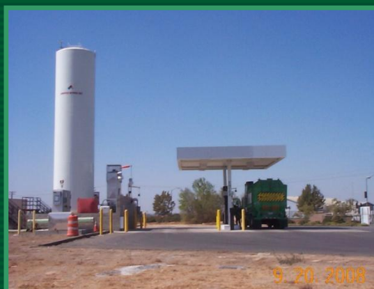
LNG Fueling Station
